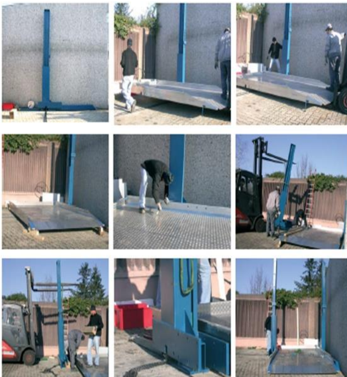
Slika 38. Montaža jednostrukog uređaja parkiranja
