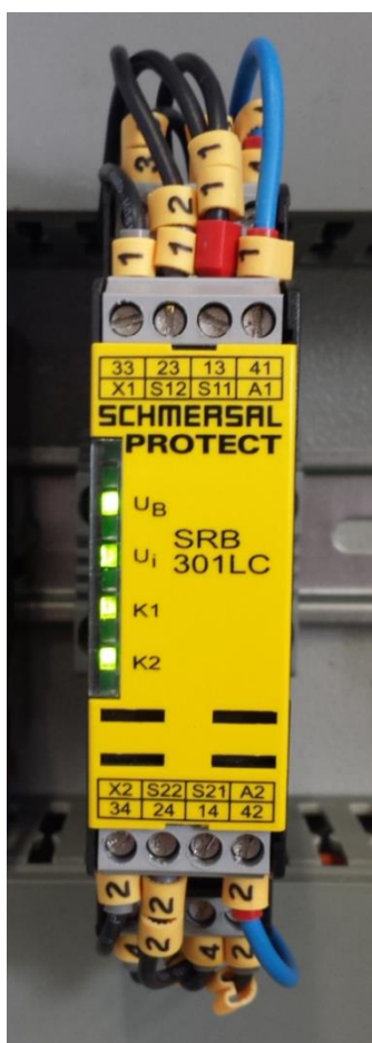
Slika 4.18 Sigurnosni relej u aktiviranom stanju
