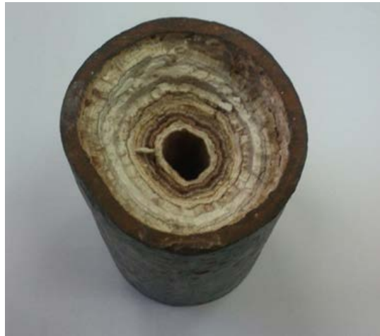
Slika 11. Kamenac u vodovodnim cijevima [16]
