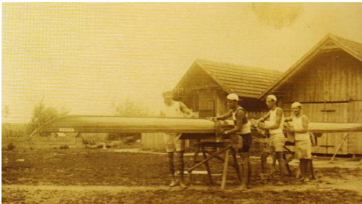
Slika 3. Klinker četverac s preklopnom građom[2]
