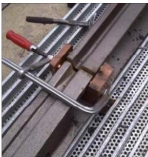
Slika 13 Radnje prije FCAW zavarivanja [13]
