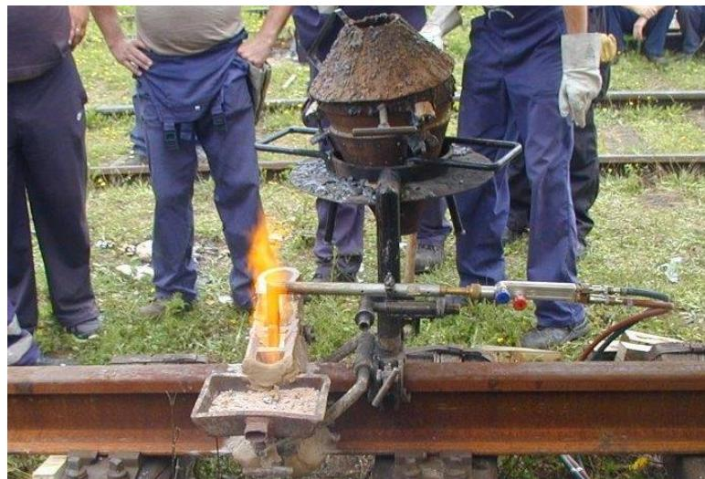
Slika 29 Predgrijavanje kalupa i krajeva tračnica prije zavarivanja [16]
