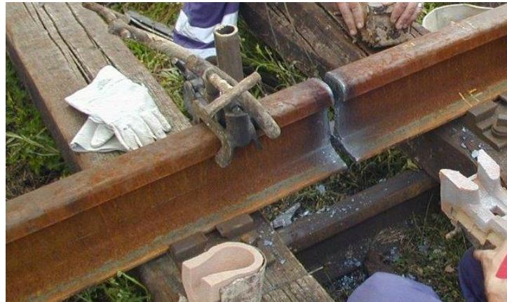
Slika 25 Priprema spoja i položaj tračnica prije zavarivanja [16]
