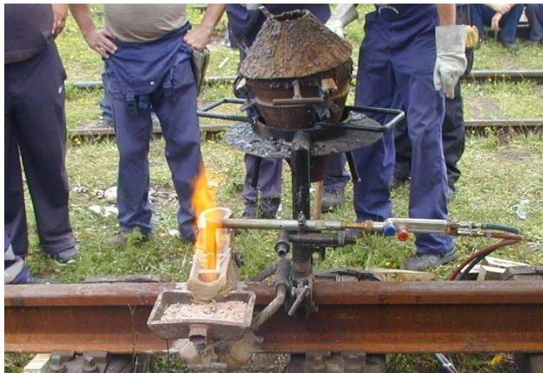
Slika 29 Predgrijavanje kalupa i krajeva tračnica prije zavarivanja [16]
