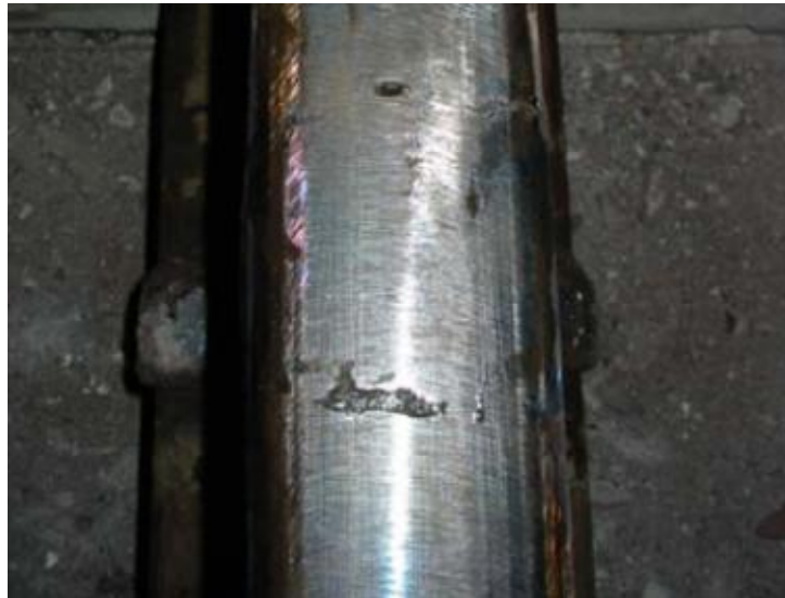
Slika 36 Opeklina od pijeska na površini glave tračnice [19]
