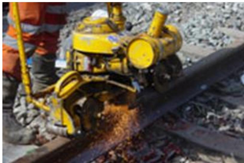
Slika 33 Završno brušenje tračnica [4]
