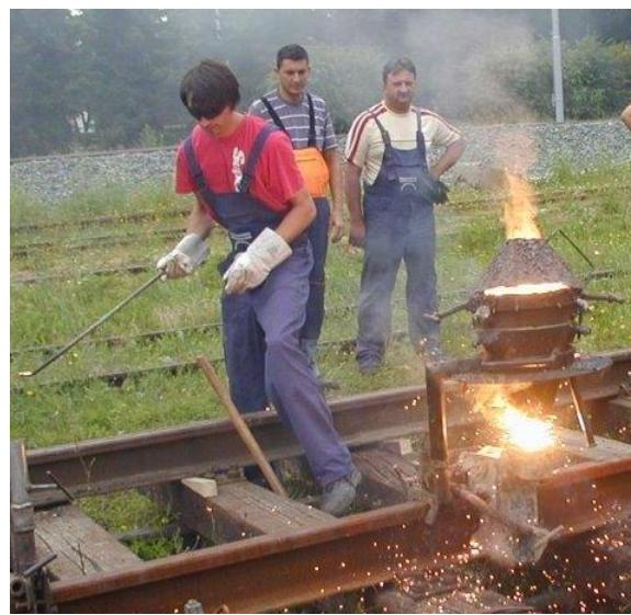
Slika 31 Izvlačenje rigle i tečenje rastaljenog čelika u kalup [16]
