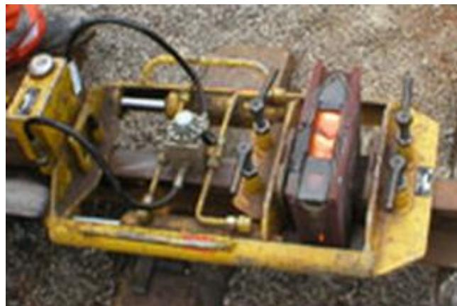
Slika 32 Hidrauličko uklanjanje kalupa i viška materijala [4]
