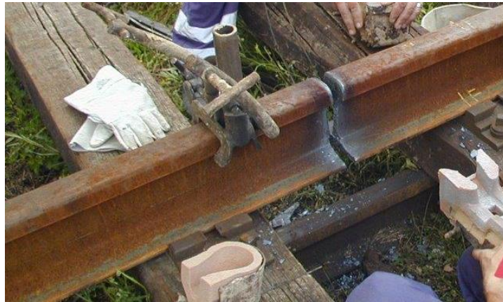
Slika 25 Priprema spoja i položaj tračnica prije zavarivanja [16]
