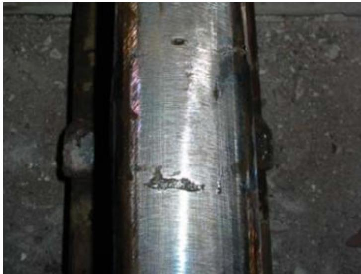
Slika 36 Opeklina od pjeska na povšini glave tračnice [19]
