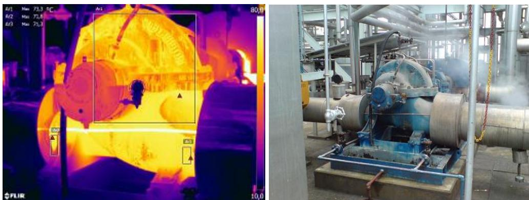
**Slika 10. Pumpa s ulaznim i izlaznim cjevovodom**
