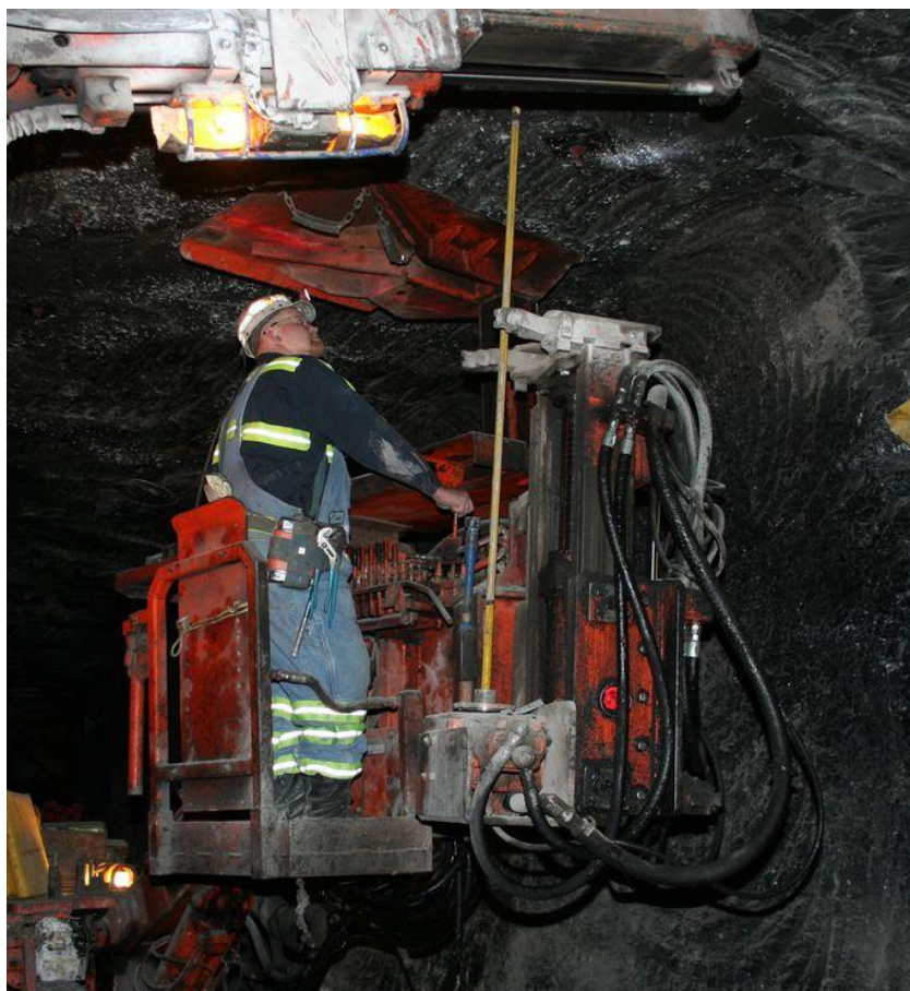
Slika 16. Ručno postavljanje sidra
