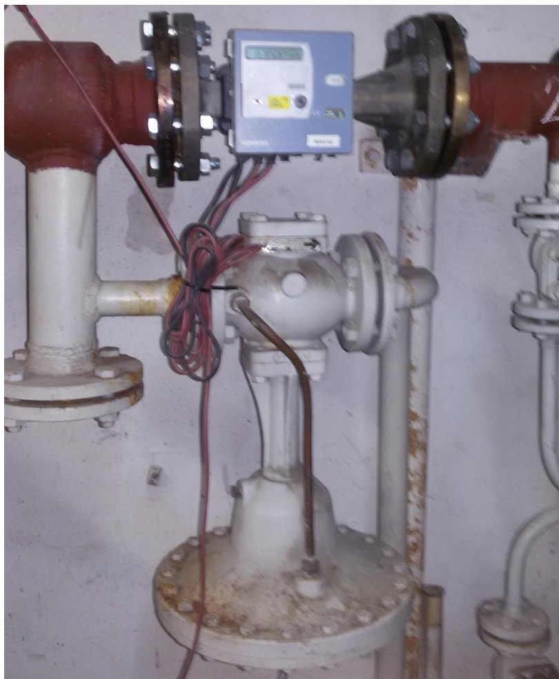
Slika 31. Sigurnosni ventil TS-Sjever FSB
