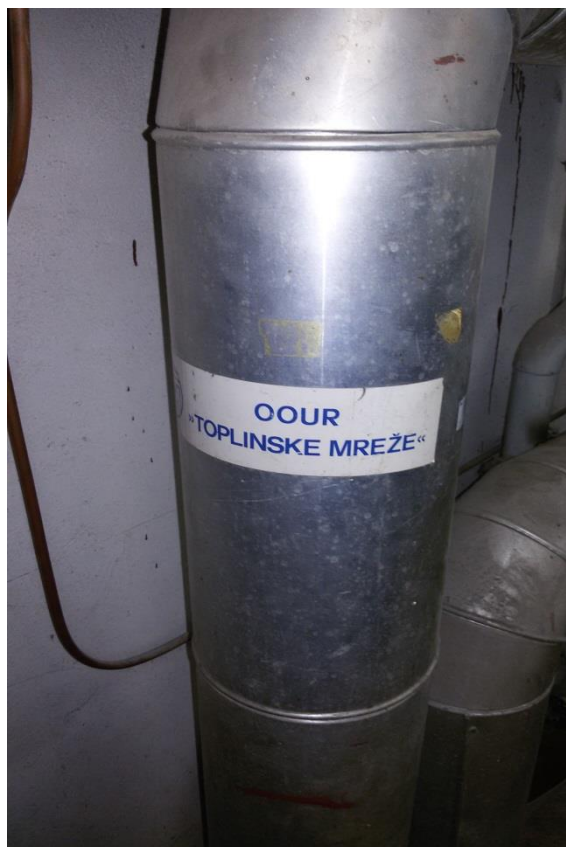
Slika 27. Glavni vod iz gradske toplinske mreže
