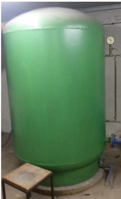
**Slika 18. Hidrofor za napajanje 'mokrog' hidranta**
