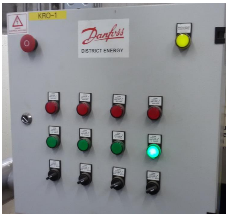
Slika 8. Indikatori i prekidači izmjenjivača topline
