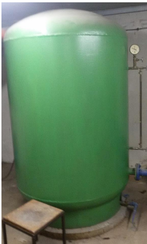
Slika 18. Hidrofor za napajanje 'mokrog' hidranta
