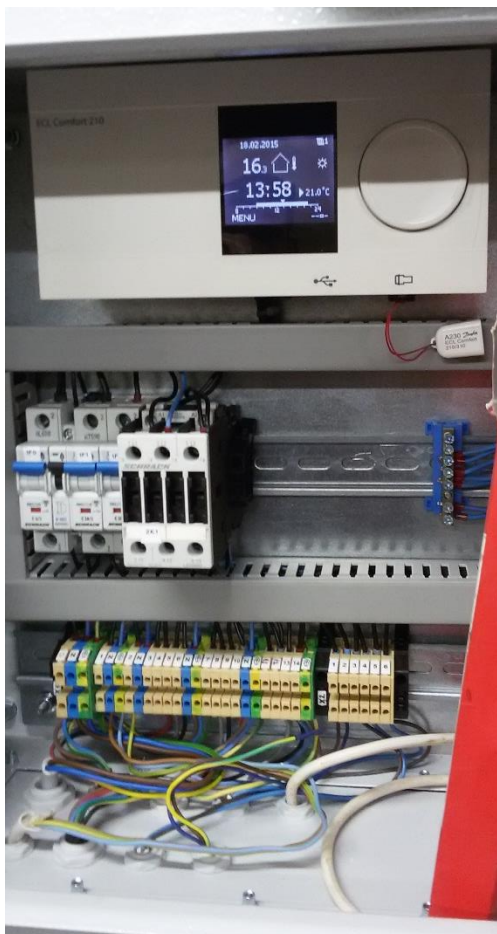
Slika 9. Kontrolno sučelje izmjenjivača topline
