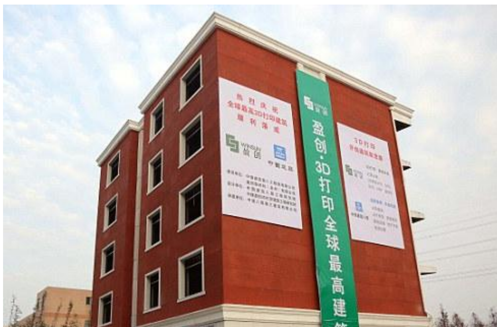
Slika 6.7. Zgrada izgrađena 3D tiskanjem
