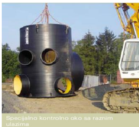
Slika 11. Specijalno kontrolno okno
