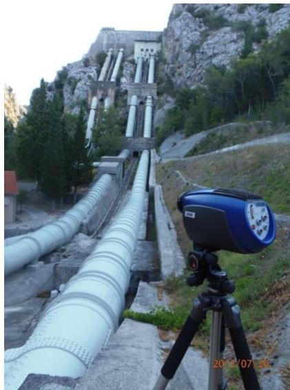
Slika 4. Tlačni cjevovod
