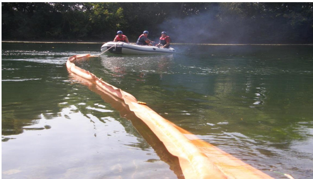
Slika 39. Postavljanje plivajuće brane, [11]
