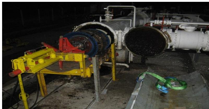
Slika 30. Lansiranje piga u naftovod hidrauličkom prešom, [11]
