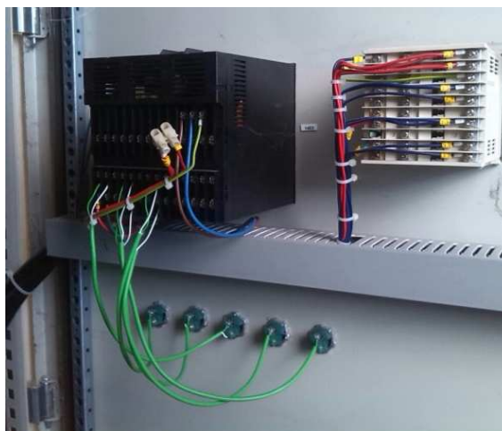
Slika 35. Mjesto spajanja računala s registratorom temperature
