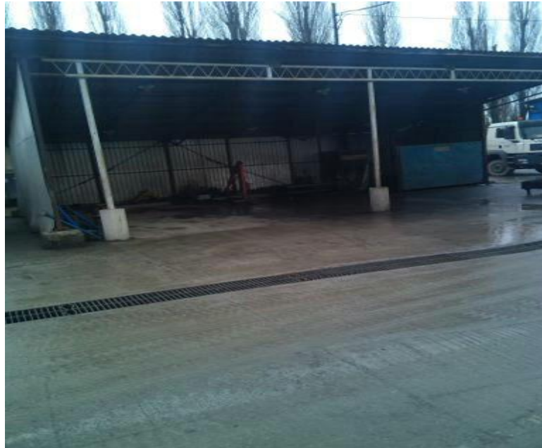
Slika 21 – Autopraona poduzeća Viadukt d.d.
