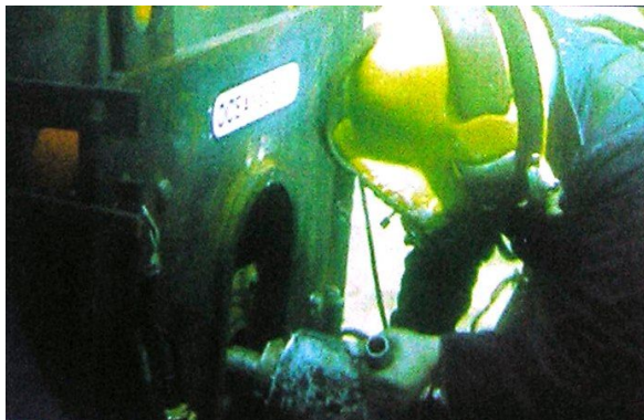
Slika 2.2.7 Podvodno zavarivanje trenjem [43]
