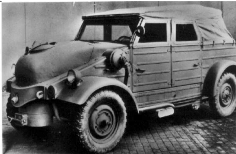
Slika 3. VW Kübelwagen pogonjen generatorskim plinom za vrijeme II. svjetskog rata [7]
