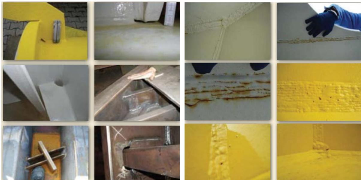
Slika 16. Priprema zavara konstrukcije vjetroelektrane za aplikaciju boje [17]
