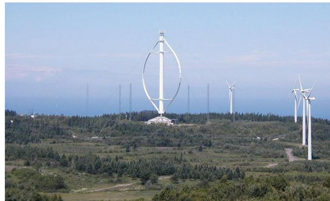
**Slika 5. Vjetroturbina s okomitom osi [4]**
