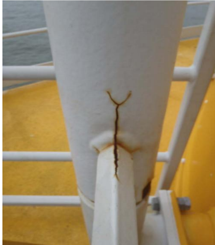
Slika 19. Nastala pukotina premaza [16]
