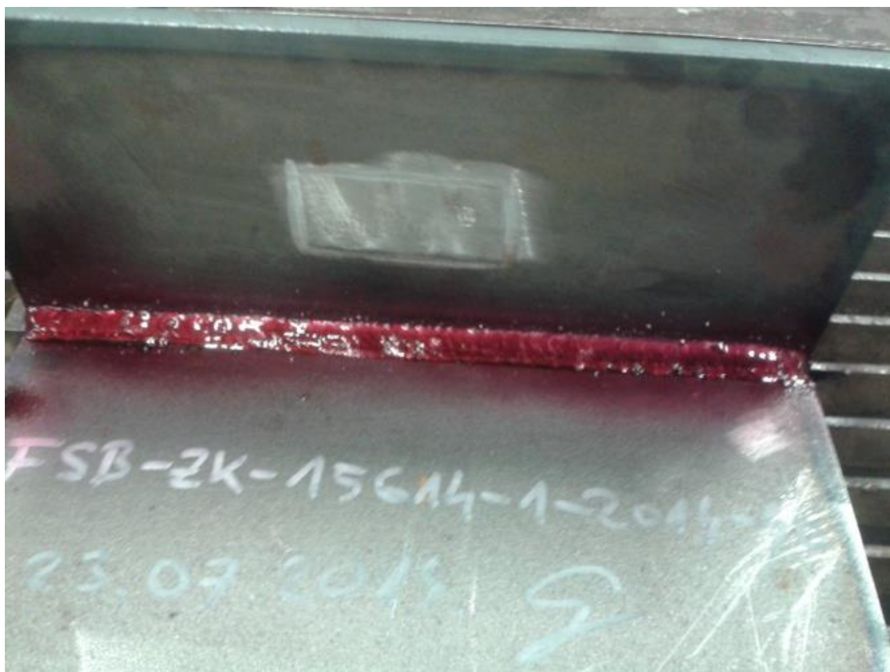
Slika 16. Penetrant na zavaru
