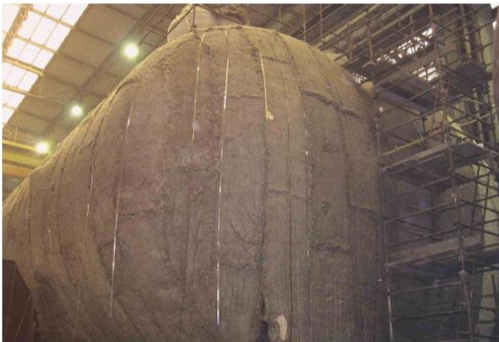
**Slika 2. Toplinska obrada tlačnog kotla [5]**
