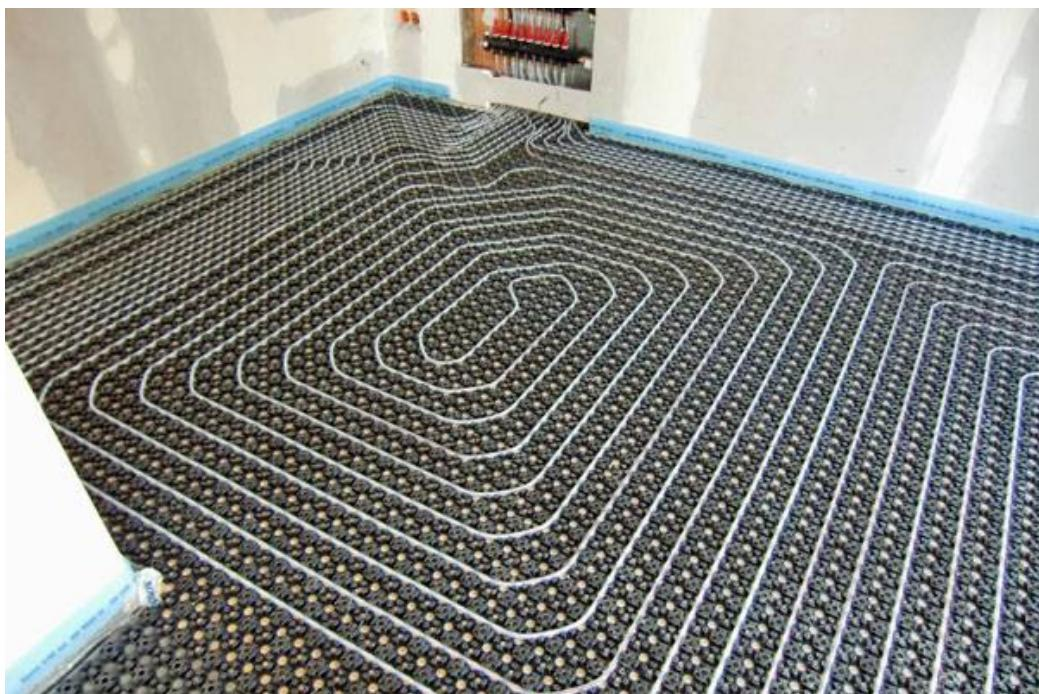
Slika 3.1 Tecto ploča za pozicioniranje
