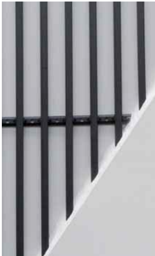
Slika 3.2 Ugradnja registra u žbuku
