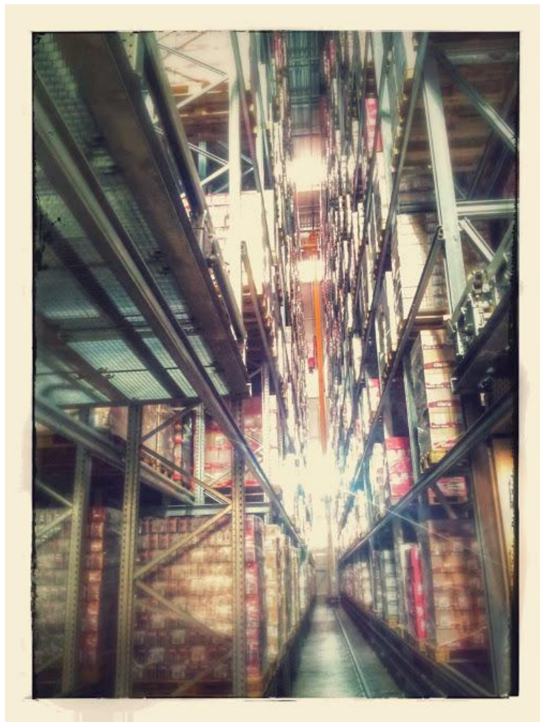
Slika 41. S/R dizalica u prolazu
