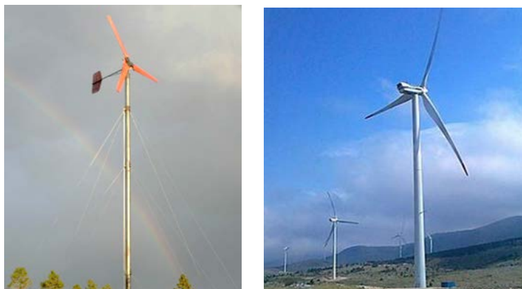
Slika 6 - Pidržani čelični (lijevo) i betonski stup (desno) [9]
