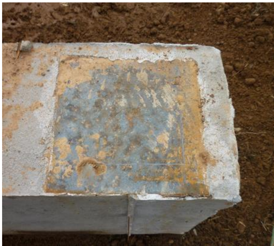
Slika 24. Temelj čeličnom pločom
