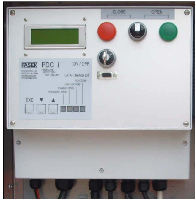
Slika 15. Elektronički LBC
