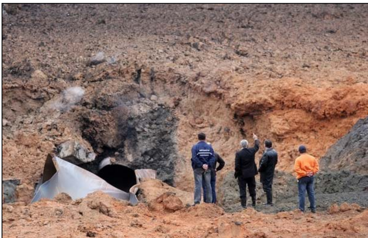
Slika 4. Eksplozija plinovoda, bliži pogled (Ukrajina svibanj 2007.g.) [3]
