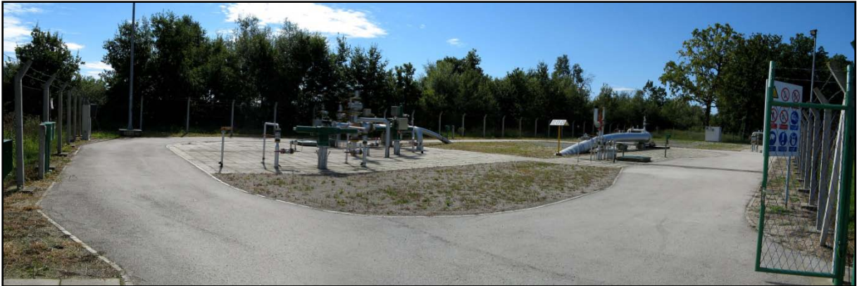
Slika 7. Plinski čvor Draganić – cijeli objekt (5 blokadnih uređaja)
