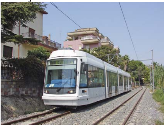
Tramvaj ŠKODA ELEKTRA 06 T
