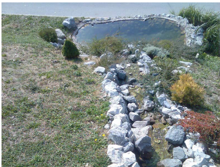
Slika 4.1.2. Bazen za provjeru kakvoće pročišćenih otpadnih voda
