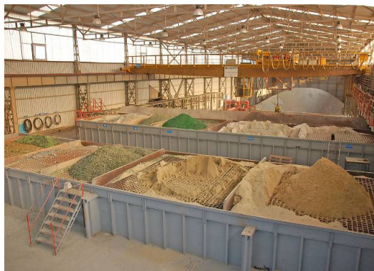
Slika 33: Natkriveno skladište kvarcnog pijeska i sode
