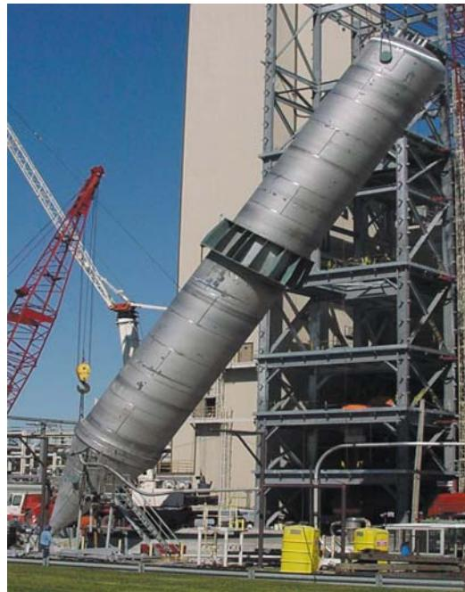
Slika 5.5. Prikaz postavljanja SSP reaktora u SSP postrojenje [32]
