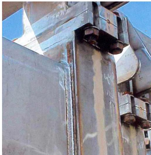
*Slika 5.1. Primjer zavarivanja raznorodnih metala FCAW-om. [4]*
