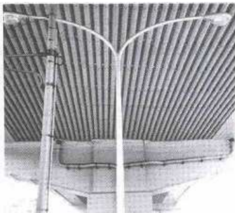
Slika 5.9. Vijadukt čija je donja površina izvedena od metalne pjene /25/
