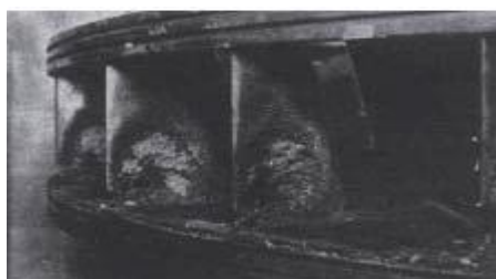
Slika 54. Oštećenja zbog kavitacijske erozije na ulazu vode u rotor Francisove turbine od Cr čeličnog lijeva [4]
