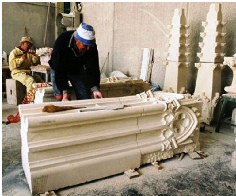
Slika 14. Restauracija kamenog detalja sa Katedrale u Zagrebu
