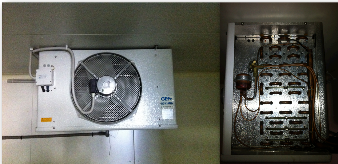
Slika 6. Isparivač
