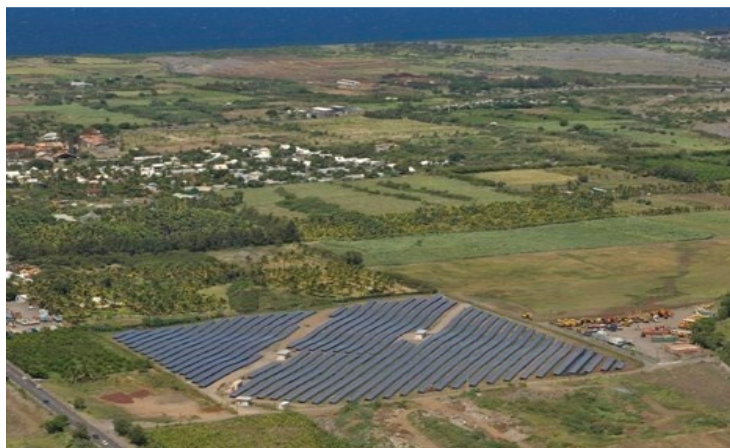
Slika 27. Primjer PV elektrane u Bugarskoj
