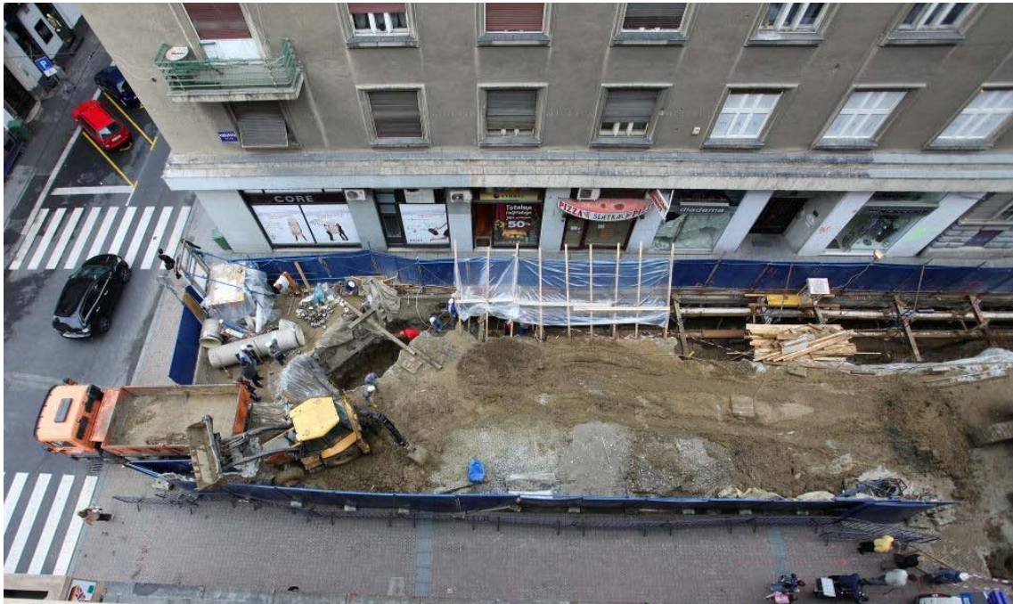
Slika 1.1 Primjer građevinskog iskopa
