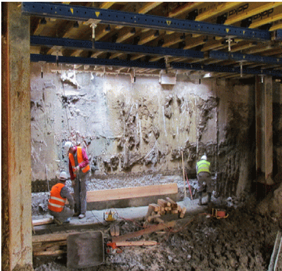
Slika 3.1 Radnici unutar iskopa
