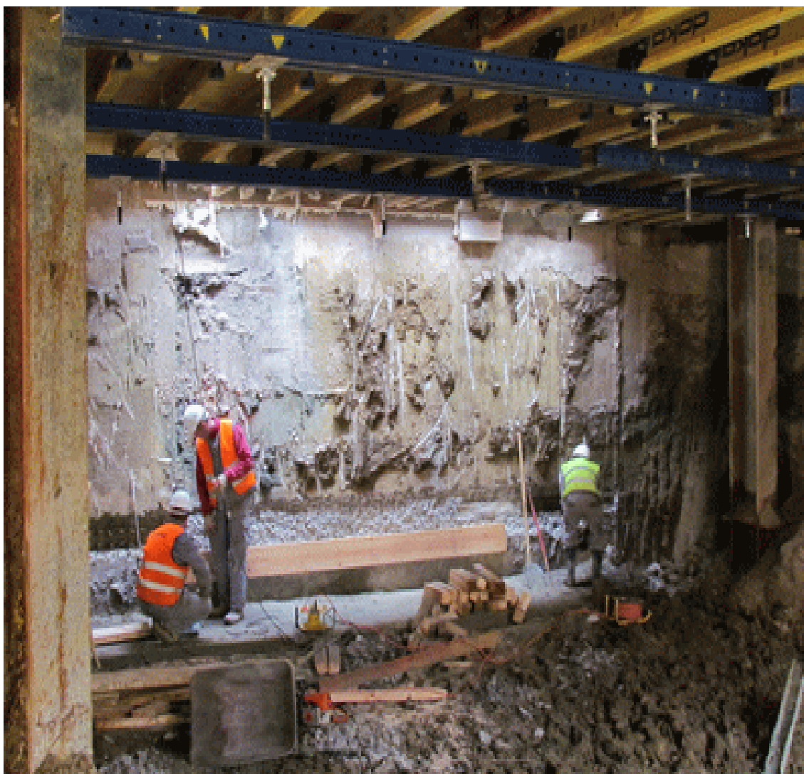
Slika 3.1 Radnici unutar iskopa
