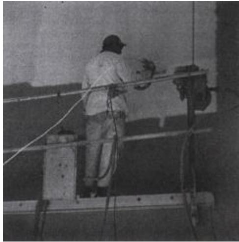
Slika 18. Metalizacija - jedan od postupaka primjene cinčanih prevlaka [11]
