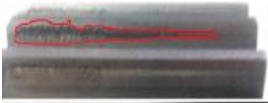
Slika 17. Oštećenje boka zbog vertikalnih pomaka[6]
