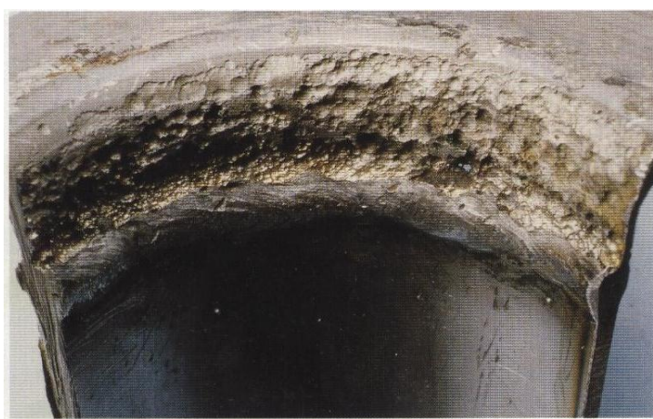
Slika 21. Oštećenja u području zavarenog spoja izazvana uzajamnim djelovanjem rupičaste i interkristalne korozije, AISI 308, slana voda, kiseline, dvije godine [47]
