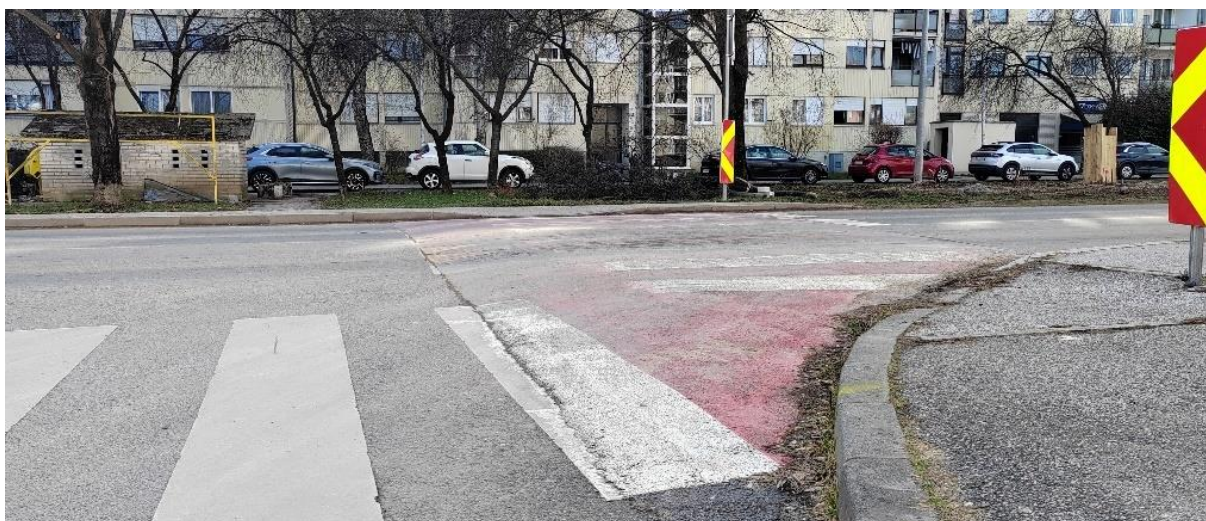
Slika 72. Izgled izvedenog uspornika na kolniku, Sarajevska cesta
