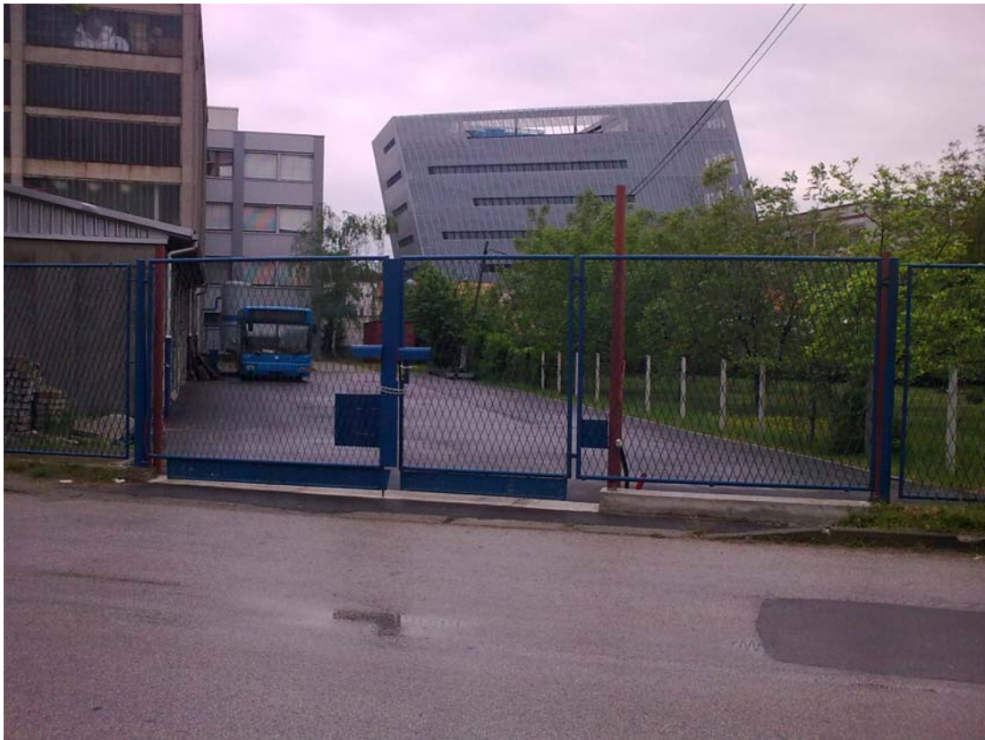
Slika 1.1. Postojeće stanje ograde i vrata sjevernog dvorišta FSB-a
