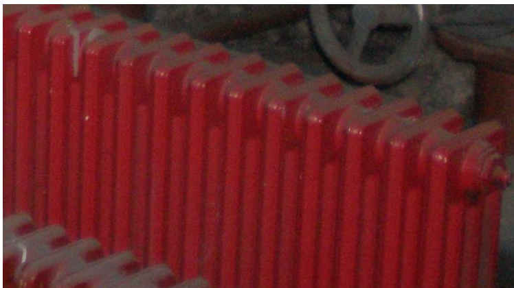
Slika 12. Radijatori u podsustavu predaje topline
