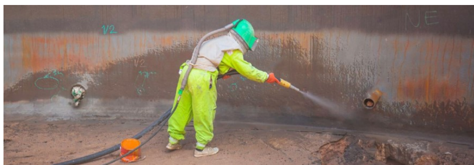
Slika 17. Čišćenje mokrim mlazom abraziva [36]
