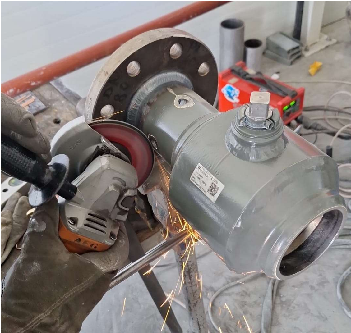
Slika 25. Priprema površina za zavarivanje priključaka
