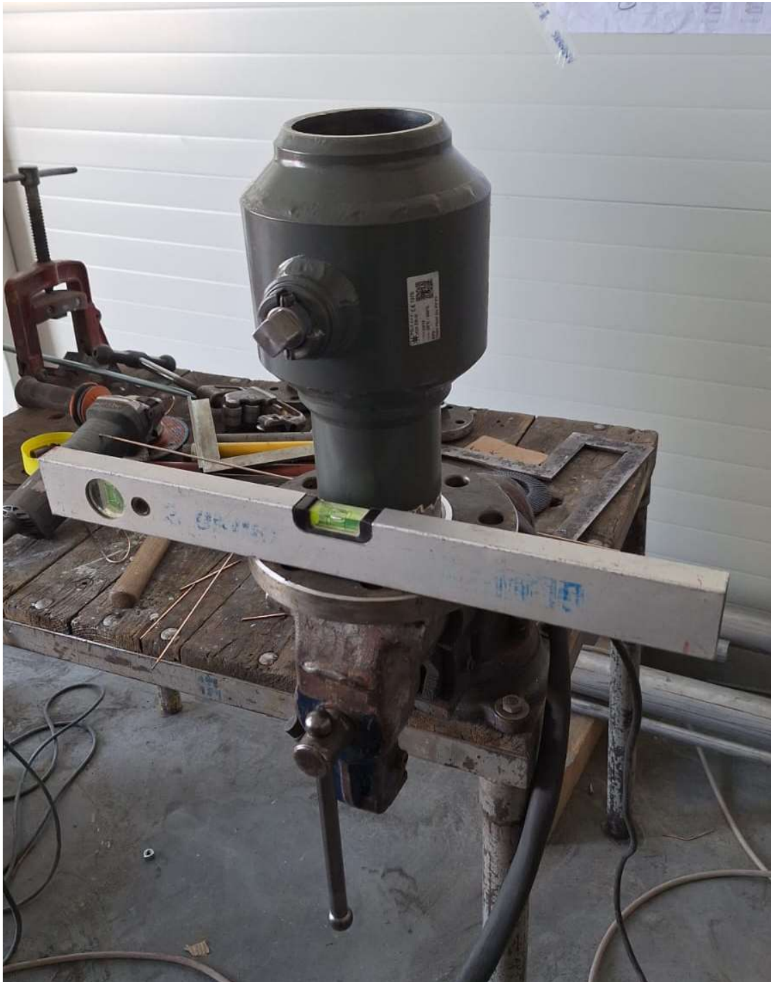
Slika 21. Dovođenje prirubnice i ventila u međusobni položaj
