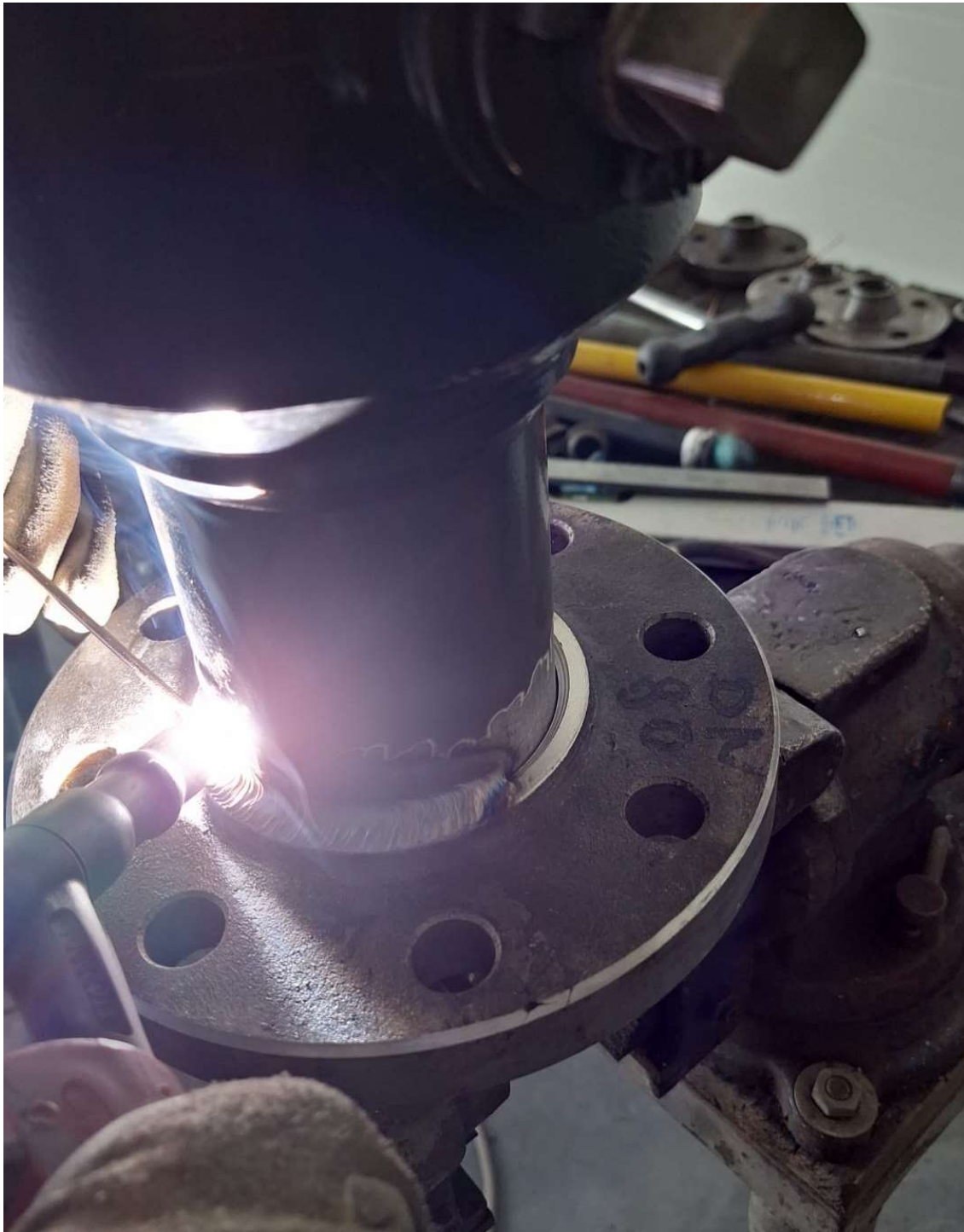
Slika 23. Zavarivanje TIG postupkom
