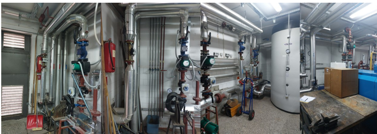
Slika 7. Prikaz postojećeg dijela strojarnice
