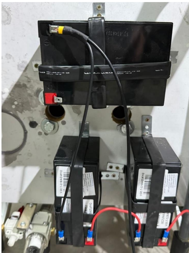
Slika 45. Napajanje akumulatorima
