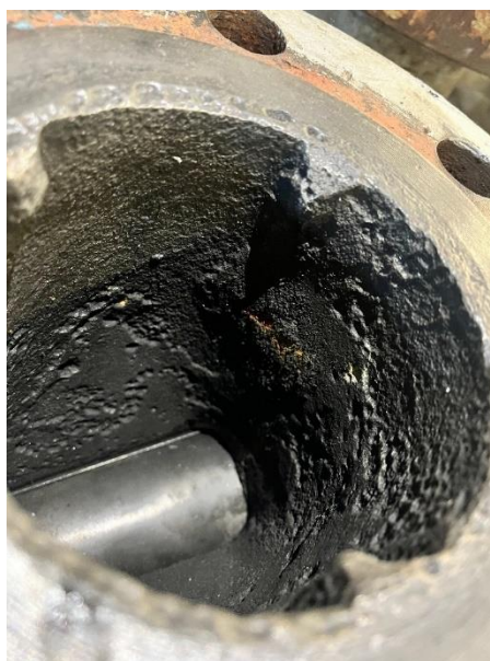
Slika 25. Kavitacijska oštećenja na ventilu
