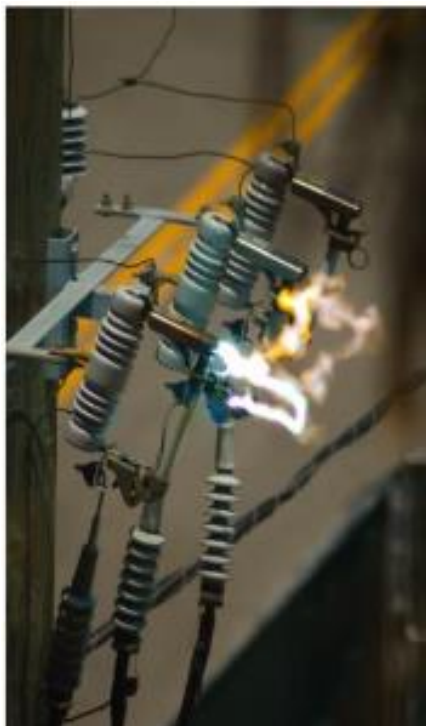
Slika 18. Pojava električnog luka [3]
