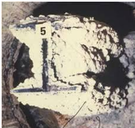
Slika 8 Formirana termoizolacijska pjena nakon požara.
