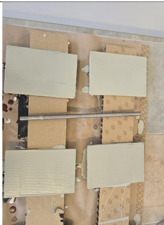
Slika 23 Nanošenje Hempel temeljnog premaza
