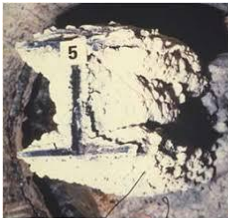
Slika 8 Formirana termoizolacijska pjena nakon požara.
