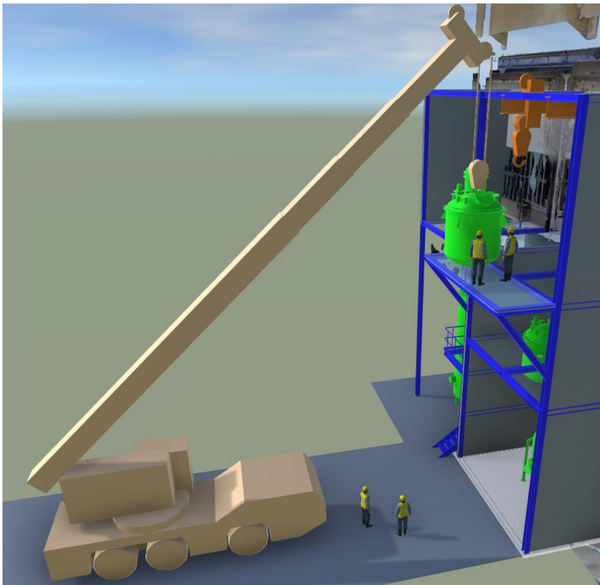
Slika 63. Skidanje reaktora s kamionske dizalice
