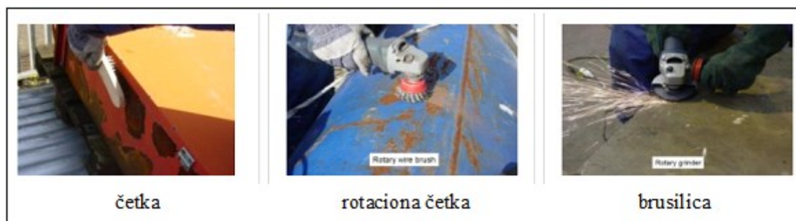
Slika 34. Neki alati za metodu ručnog čišćenja [37]
